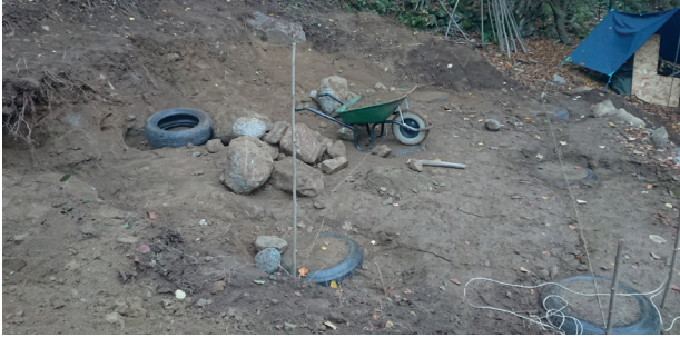
Fondation pneu, Victor, Viscos
