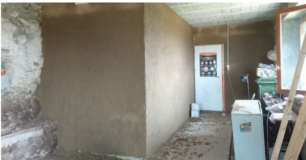
Isolation terre paille/enduits, Thibault, Hautes Savoie
