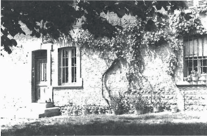
FIGURE 47 : FAÇADE DE LA PARTIE HABITATION
